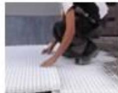
Durch das Aufeinanderlegen am Rand stabilisieren sich die Platten durch das Gewicht der Füllung von selbst.
